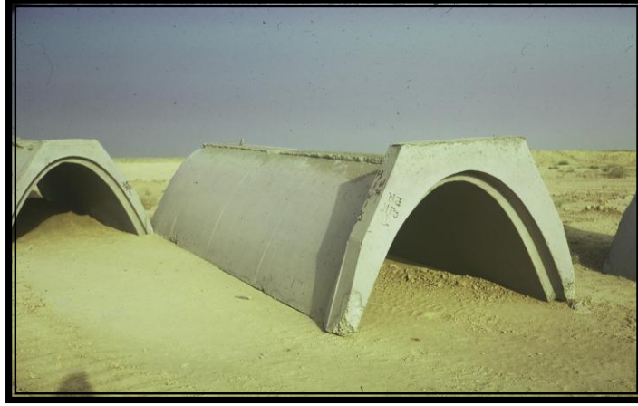
Orta Asya'da Sulamalarda Uygulanan Kanalet Üniteleri (1975)
