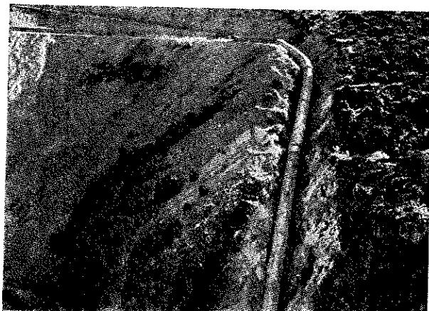
c) Giriş kısmı kurba yerleştirilmiş sifon
